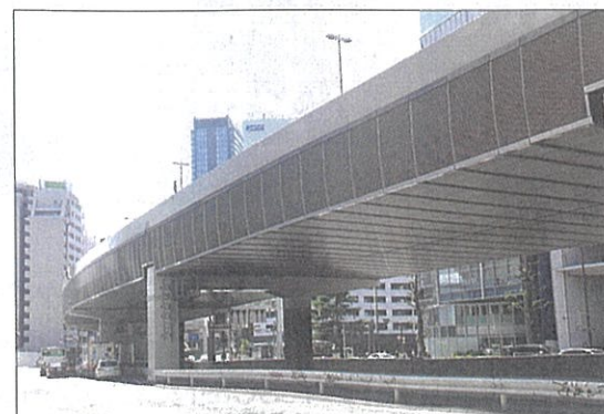
橋梁恒久足場用アルミ押出形材ルーバーパネル「ノンスルーPS」
