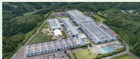
福島工場 1600 kW(売電分)+89.48 kW(自己消費分)
