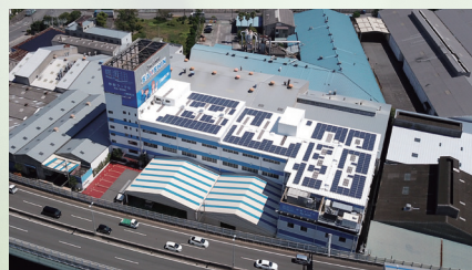
配送センター 126 kW(売電分)
